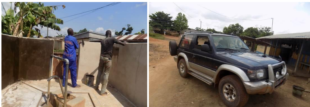
Photo 14 et 15 : Travaux de peinture après la réhabilitation de la pompe de Baffia.
