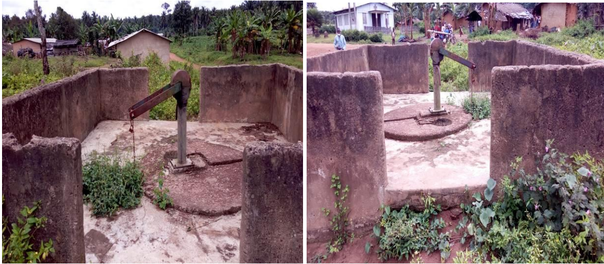
Photo 1 et 2 : Vue de la pompe à réhabiliter avant les travaux (Adamakro)
