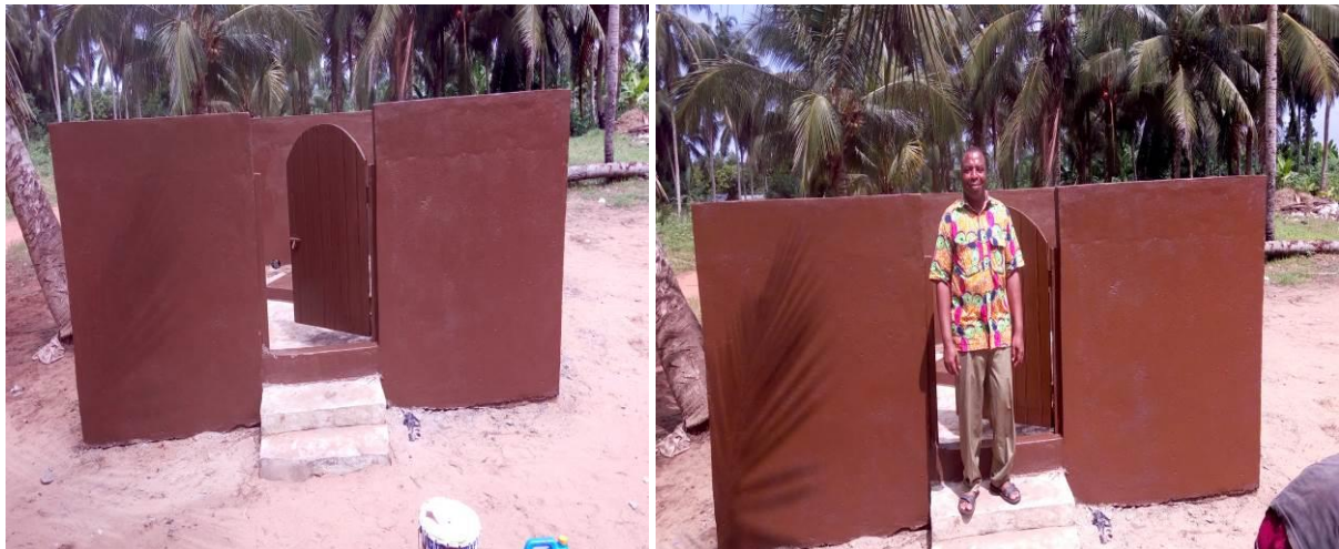
Photo 8 et 9 : Fin des travaux, vue d'ensemble de la pompe de Mélékougro avec le Directeur de l'Ecole Primaire, Présidente du Comité de Gestion de la pompe.
