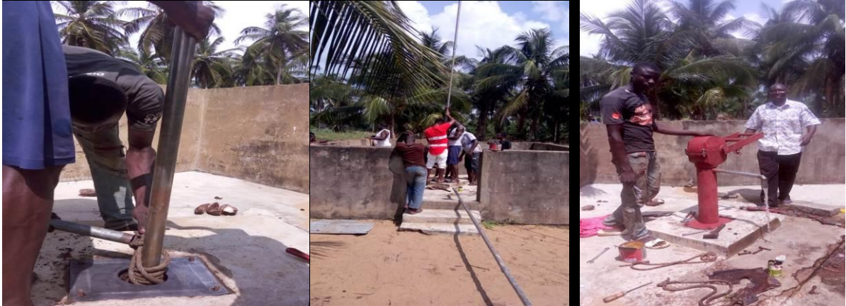
Photo 5, 6 et 7 : Vu d'ensemble de la pompe pendant la phase des travaux (Mélékougro)
