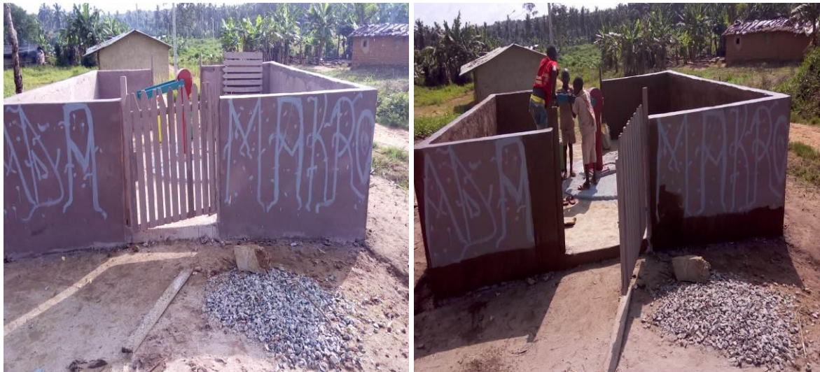
Photo 3 et 4 : Vue de la pompe à la fin des travaux (Adamakro)
