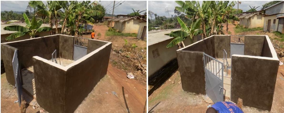
Photo 12 et 13 : Fin des travaux, vue d'ensemble de la pompe de Baffia remise à neuf avec son environnement assaini.
