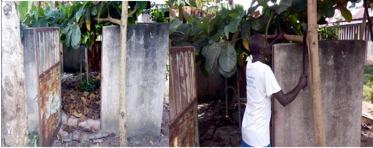
Photo 10 et 11 : Vu de l'environnement de la pompe avant les travaux (Baffia)
